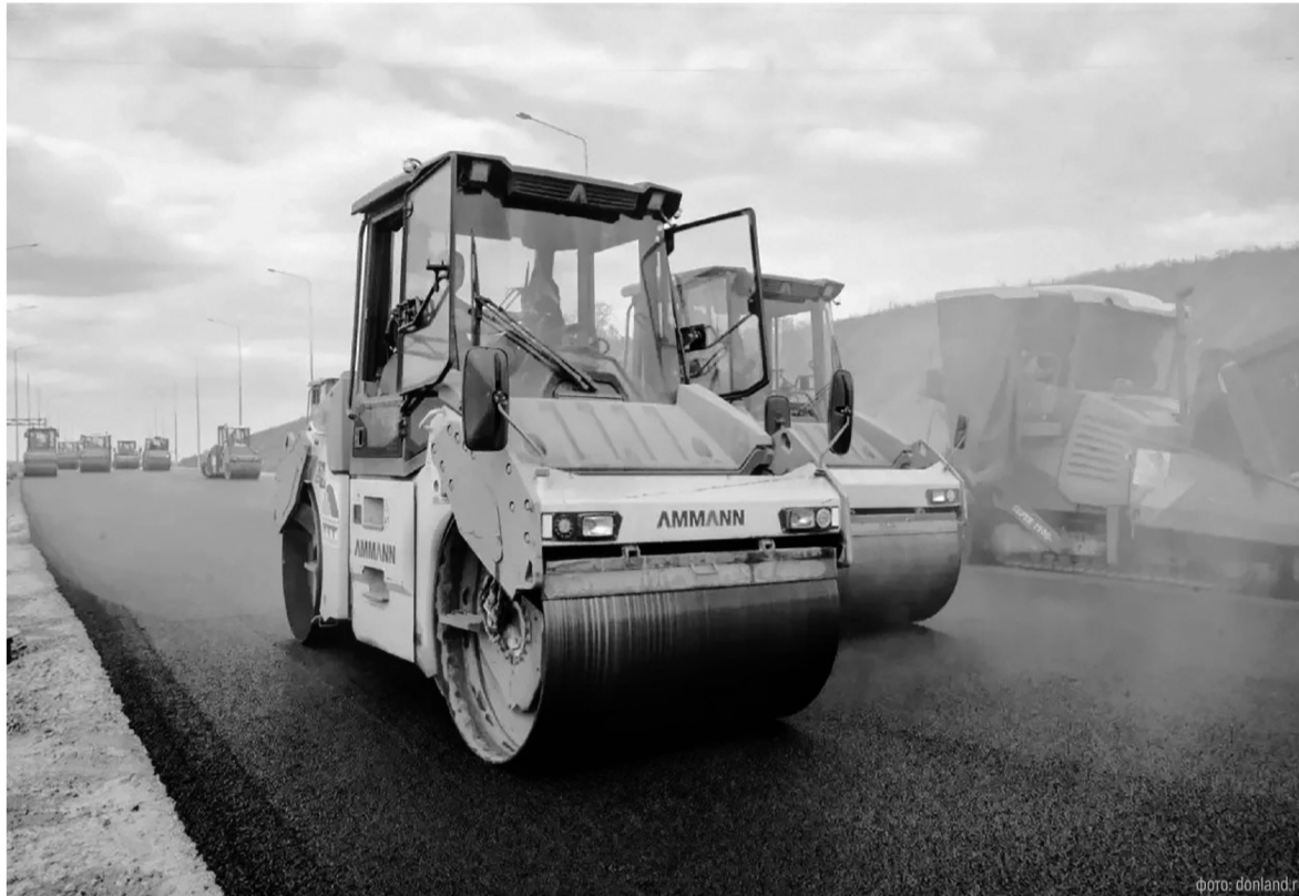
Дорожники Ростовской области приступают к ремонтным работам
