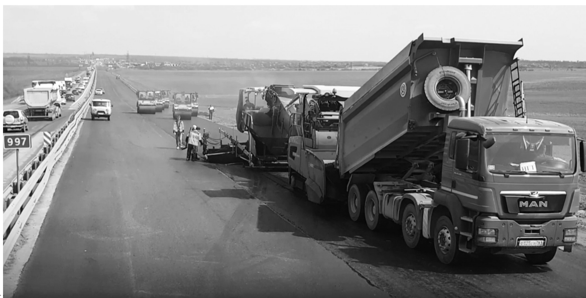
Работы на трассе уже начались
