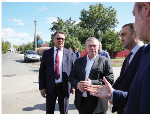
Губернатор проинспектировал капремонт дороги в ст. Кагальницкой
