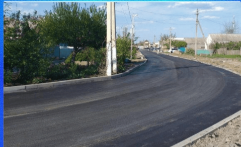
О важном Ремонт сельских дорог
