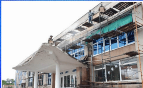
О важном Ремонт Новобатайского КСК продолжается
